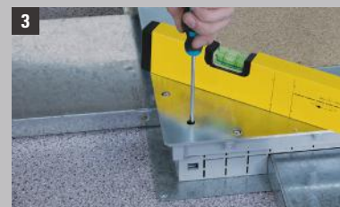
3 Отрегулировать с помощью винтов
