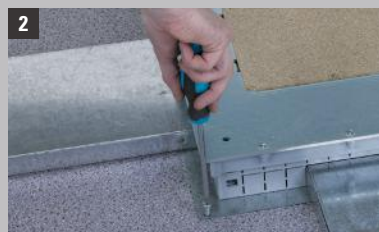
2 Вставить кабель-каналы и привинтить к полу
